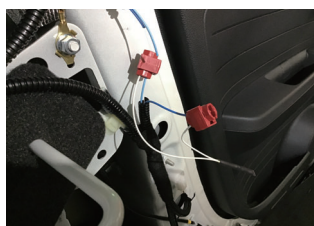
③配線（電源側）にコネクタでキャンセラーを結線する。エアバッグ側配線も絶縁処理して固定しておく。
